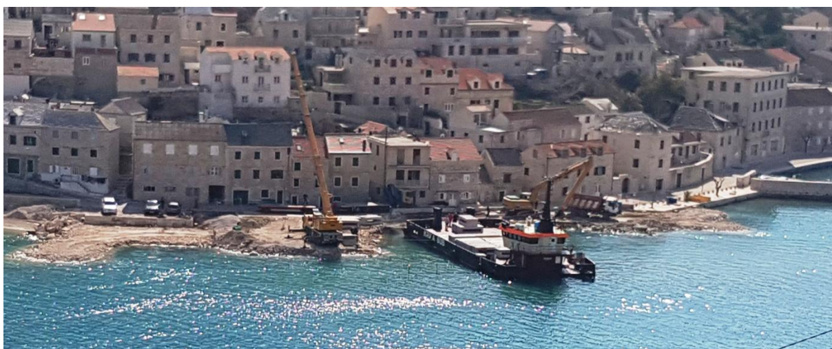
Radovi na uređenju dijela obale u Pučišćima, investitor: Lučka uprava SDŽ
